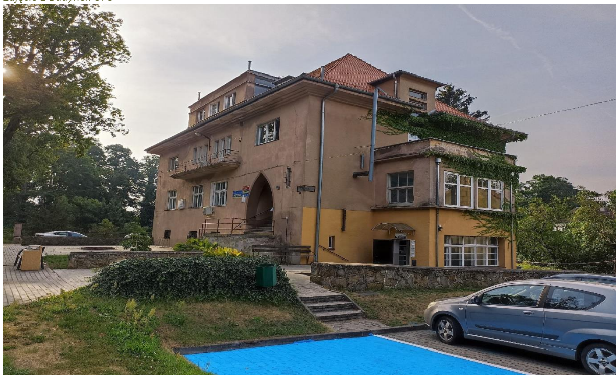
Zdjęcie 1 Budynek OPS
