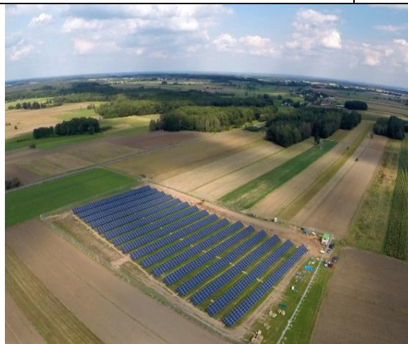
Elektrownia Jedwabne (0,71MW) 10
