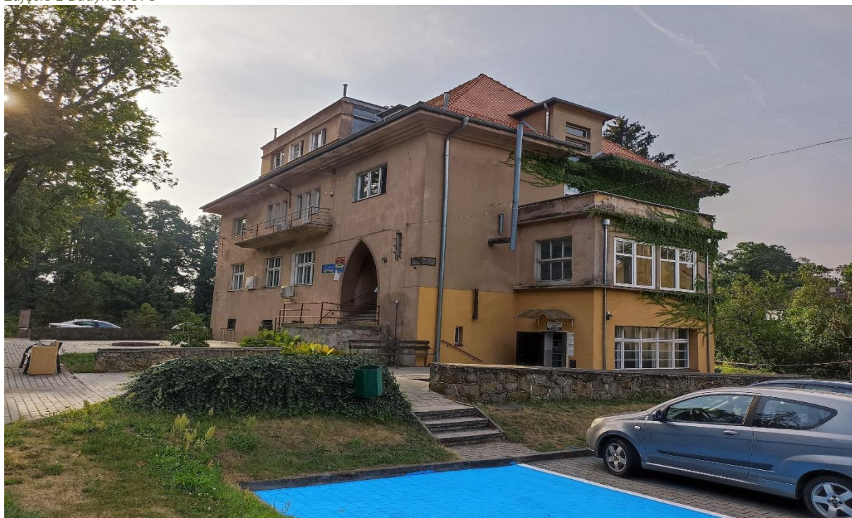
Zdjęcie 1 Budynek OPS
