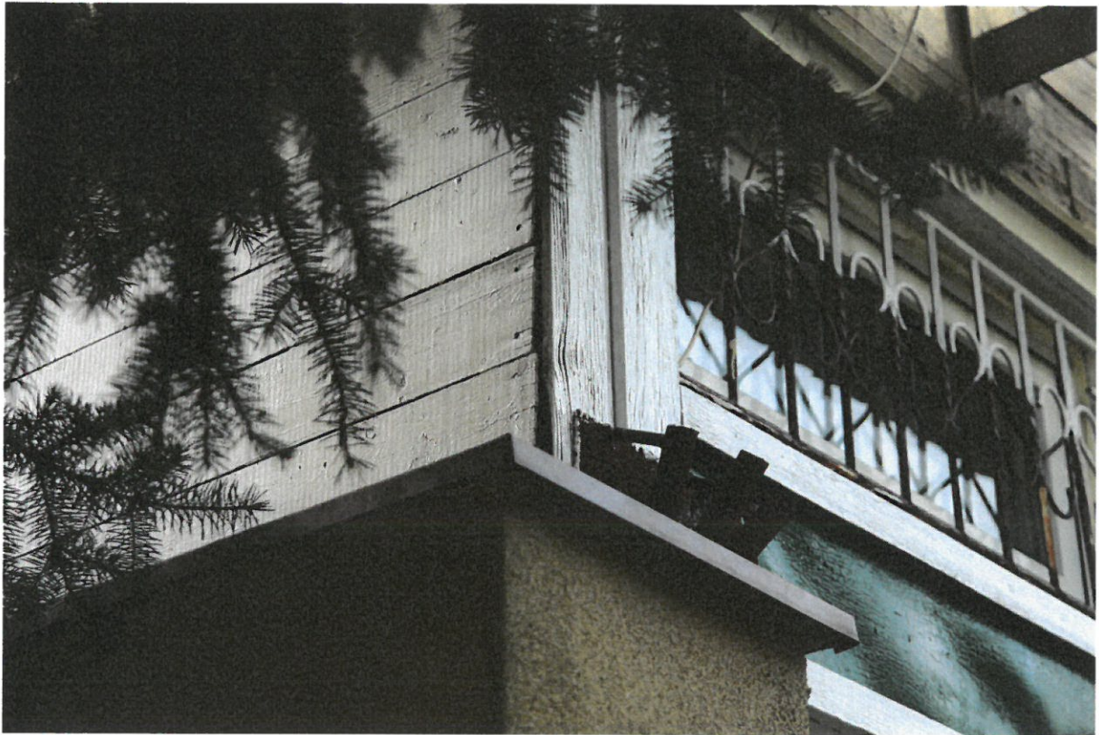
Nieszczelności poszycia zewnętrznego ścian
