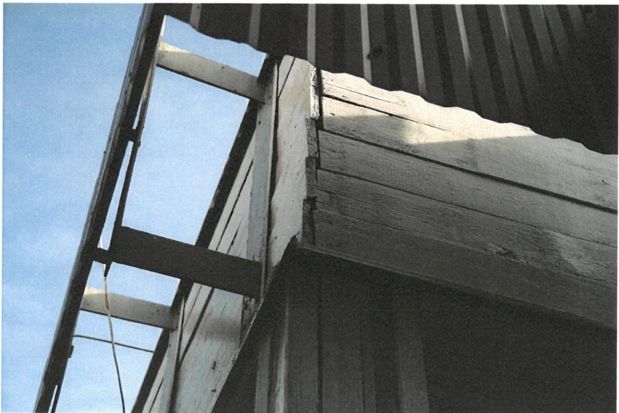
Nieszczelności poszycia zewnętrznego ścian
