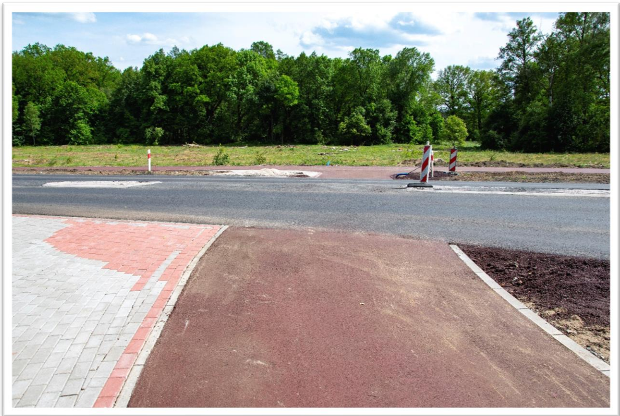
Budowa ścieżek rowerowych na odcinku Czerna - Iłowa
