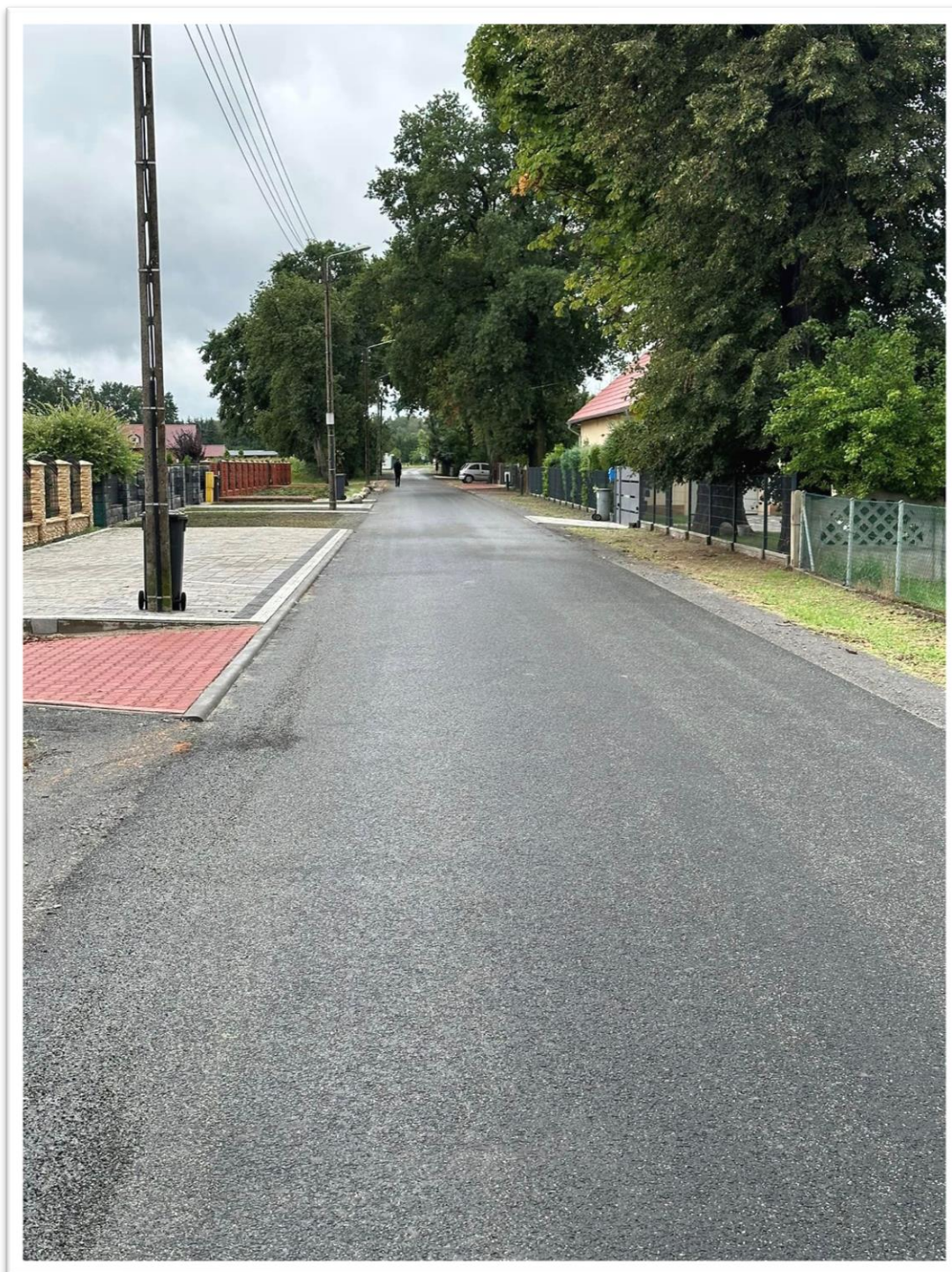
Remont ulicy Drzymały
