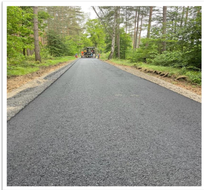
Remont drogi gminnej na odcinku Iłowa – Kowalice
